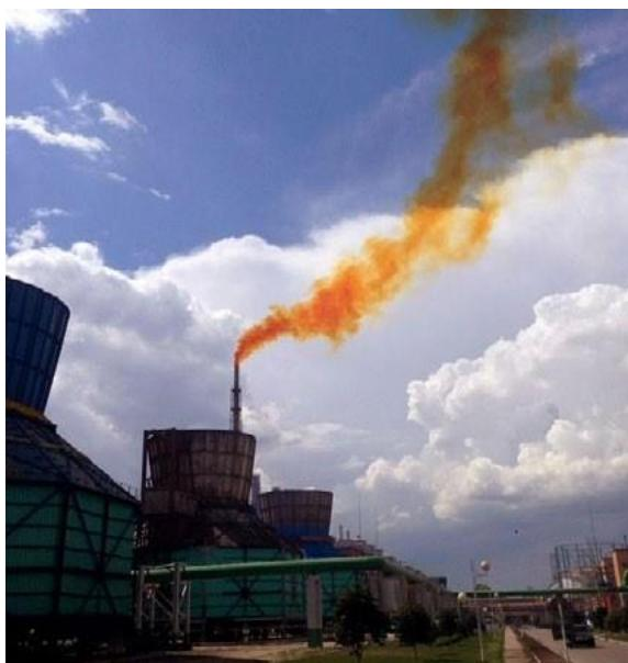
*Рис. 15.* Выброс диоксида азота, «лисий хвост»,
